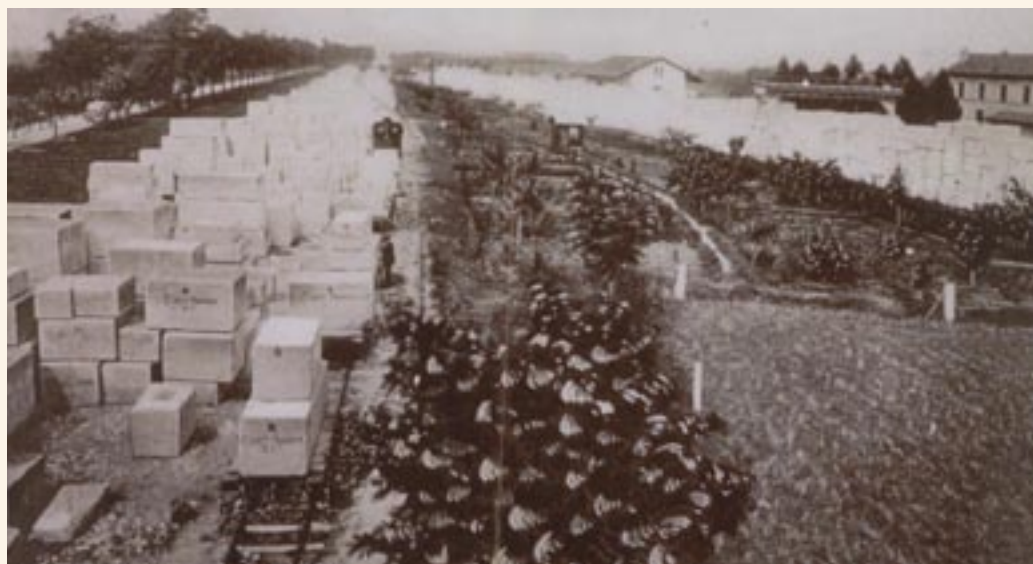
La gare de Jardres avec ses blocs de pierre et à gauche la route nationale en direction de Poitiers.
